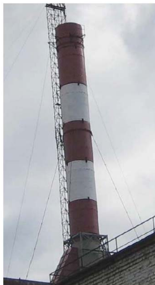
Рис.4. Самонесущая стеклопластиковая дымовая труба ТЭЦ-1 г. Челябинска
